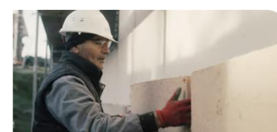
Panneaux isolants en fibres de bois
